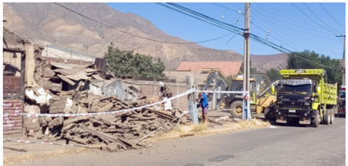
La demolición y limpieza demorará alrededor de cuatro días.
