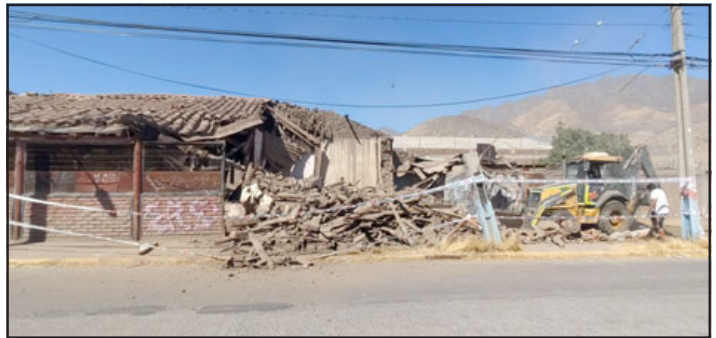
Este martes 4 de marzo comenzó la demolición de la casa abandonada ubicada en Avenida Maipú esquina Manuel de Lima.
