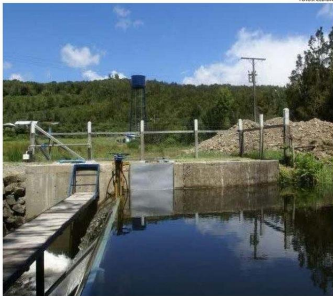
PARTE DE LAS INSTALACIONES DEL APR DE NERCÓN LOS AROMOS, GAMBOA ALTO.
