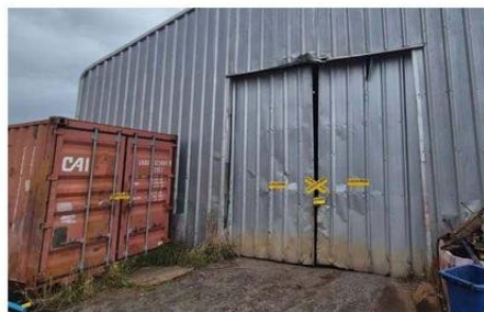
GALPÓN SE OCUPABA COMO BODEGA Y ESTACIONAMIENTO.
