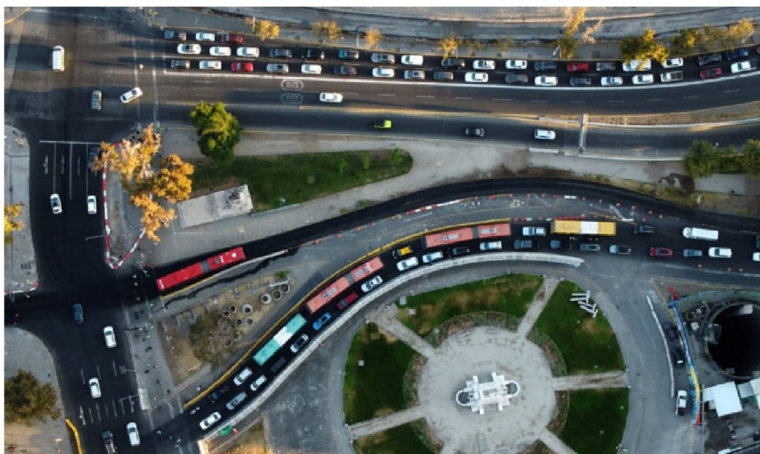
► En el nudo de Baquedano actualmente se están realizando trabajos en el marco del proyecto eje Alameda-Providencia.
