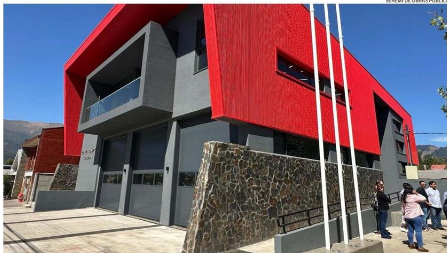
EL NUEVO EDIFICIO SE LEVANTÓ EN UNA SUPERFICIE DE 570 METROS CUADRADOS Y CONSTA DE 2 PISOS CONSTRUIDO EN HORMIGÓN ARMADO EN TODA SU ESTRUCTURA.
