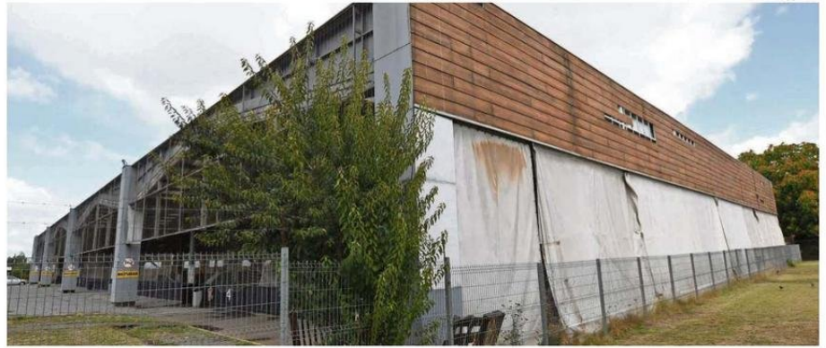
LOS GALPONES CON CANCHAS DE FUTBOLITO QUE CONSTRUYÓ M11, AHORA PASARÁN A SER MUNICIPALES.
