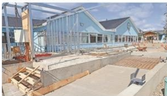
Parte de las obras que se ejecutan en el Colegio Luterano.
