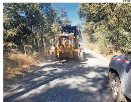
TRABAJOS APUNTAN A UNA MAYOR CONECTIVIDAD Y SEGURIDAD.
