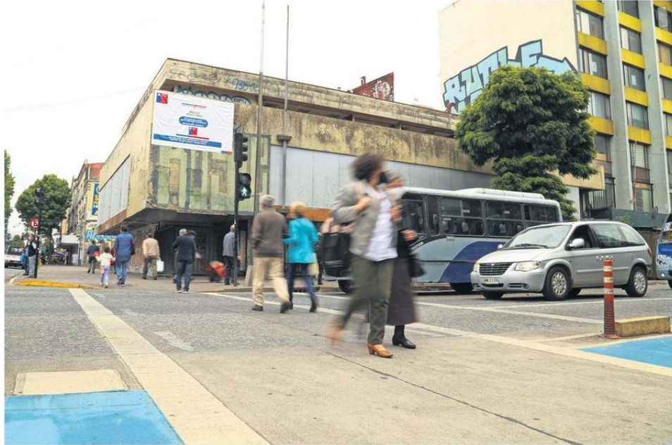
El edificio que alguna vez albergó a la Contraloría se encuentra en desuso desde el terremoto de 2010.
