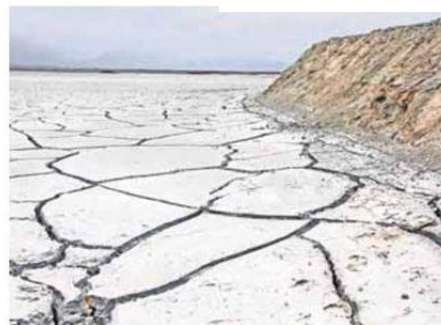
EL DEPÓSITO ES UTILIZADO POR LAS DIVISIONES RT, CHUQUI Y DMH.
