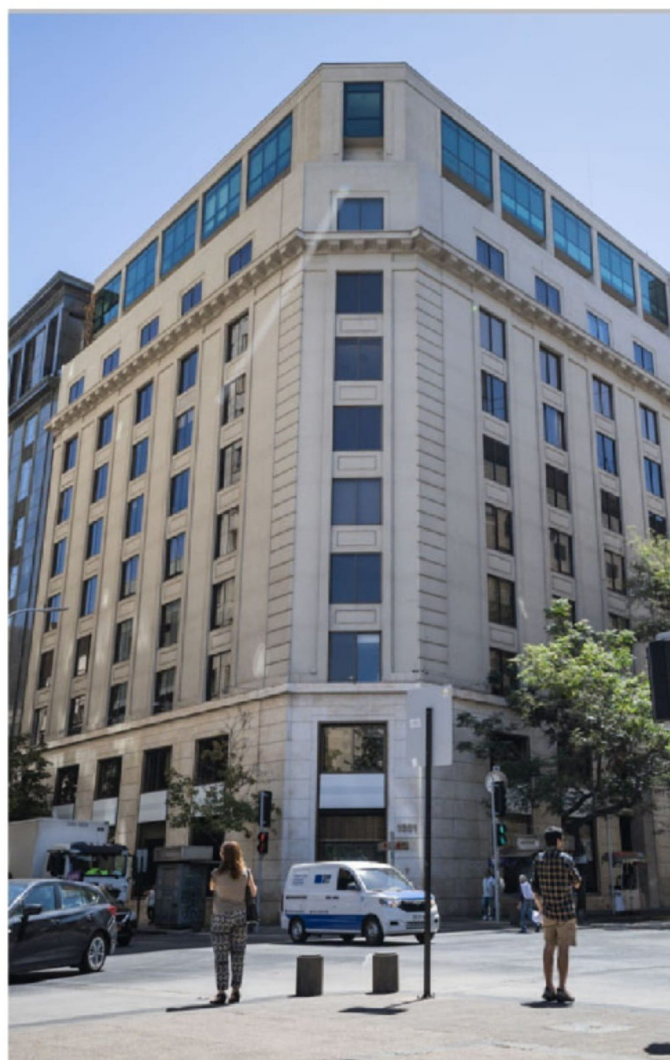
► En este edificio se instalarán los gabinetes del nuevo ministro o ministra de Seguridad Pública, y de las subsecretarías de Seguridad Pública y Prevención del Delito.
