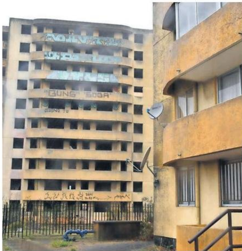
Hoy comienza formalmente la demolición de la torre C del complejo Puerto de Palos de Hualpén.
