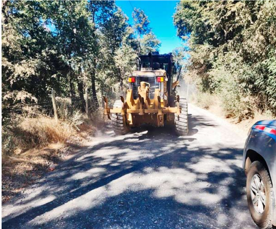
La ruta N-555 Los Pellines ha sufrido un notable deterioro debido al alto flujo de vehículos que combaten el fuego.
