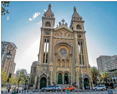
La Iglesia de los Sacramentinos perdió ornamentos de su fachada, pero aún no es reparada.
