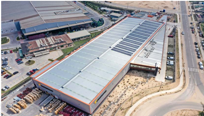
Instalaciones del Centro de Distribución de Tecnored en Placilla, Valparaíso.
