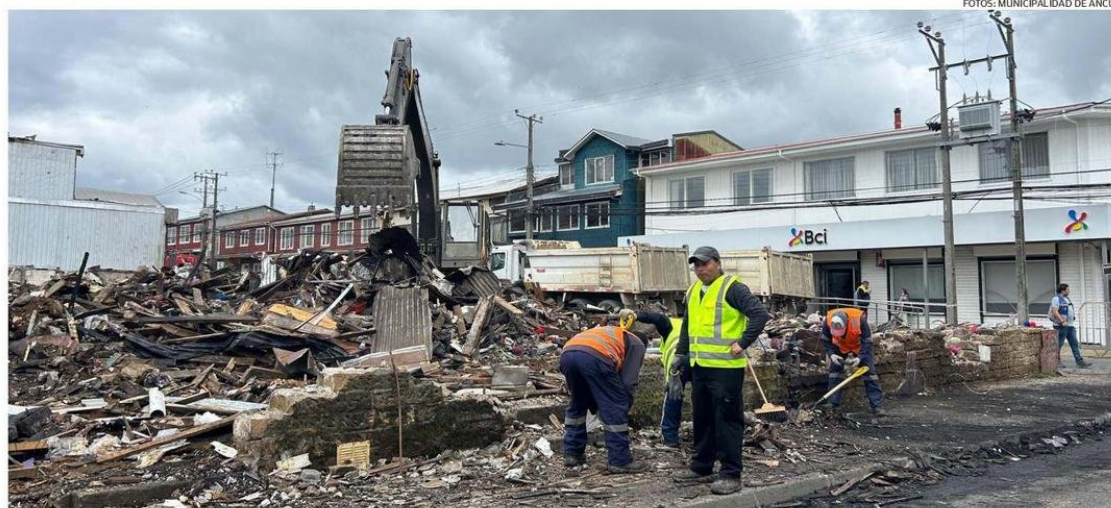
TRABAJO EN LA ZONA AFECTADA POR LAS LLAMAS.
