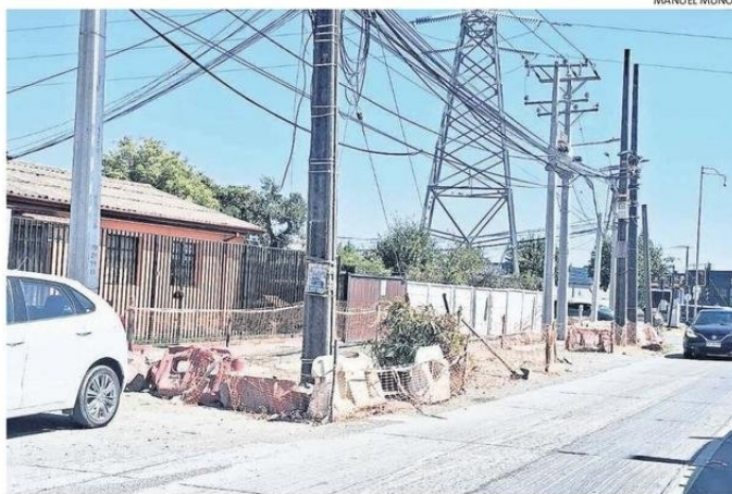
LOS POSTES ESTÁN EN PLENA CALZADA, TANTO JUNTO A LA AUTOPISTA COMO AL LLEGAR A CLAUDIO GAY.
