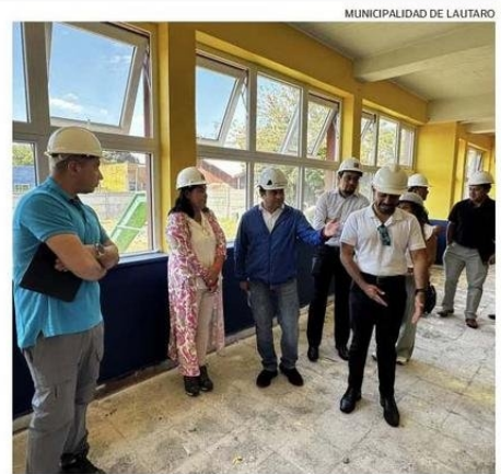
LOS TRABAJOS ESTÁN EN PLENA EJECUCIÓN. SE MODIFICARÁN EL VENTANAL, PISOS Y CALEFACCIÓN.
