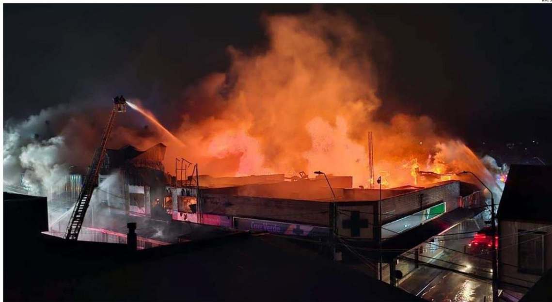
LAS LLAMAS ARRASARON LOS LOCALES COMERCIALES UBICADO EN CALLE ELEUTERIO RAMÍREZ, UNA DE LAS PRINCIPALES DEL NORTE DE LA ISLA.
