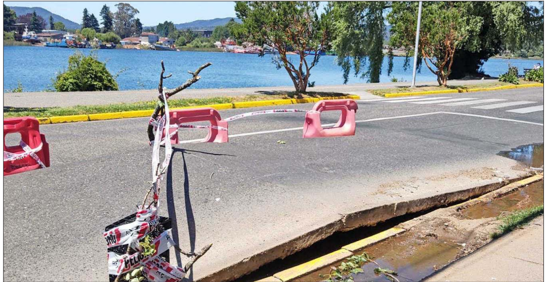
Junto al río Calle Calle. La avenida Arturo Prat, tradicional costanera de Valdivia, vio alzado su pavimento durante la ola de calor de diciembre pasado.
