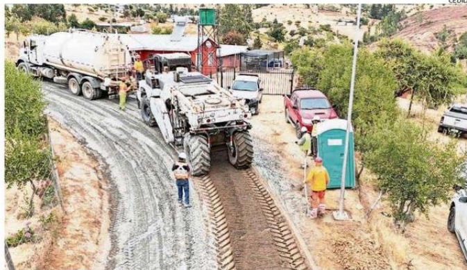
EL PROCESO MEJORA LA RESISTENCIA DEL TERRENO MEDIANTE LA APLICACIÓN DE CAL O CEMENTO.
