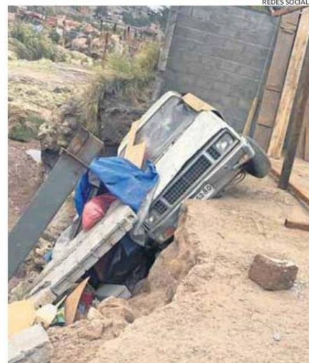
UNA DE LAS CASAS QUE FUE AFECTADA EN EL PUEBLO DE CASPANA.
