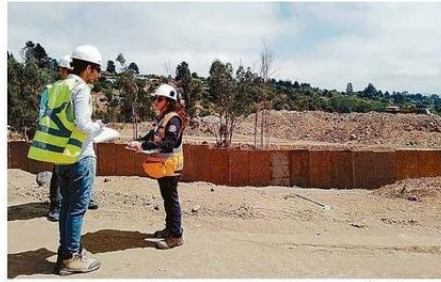
TRABAJOS FUERON SUSPENDIDOS POR UN PERIODO DE 30 DÍAS.
