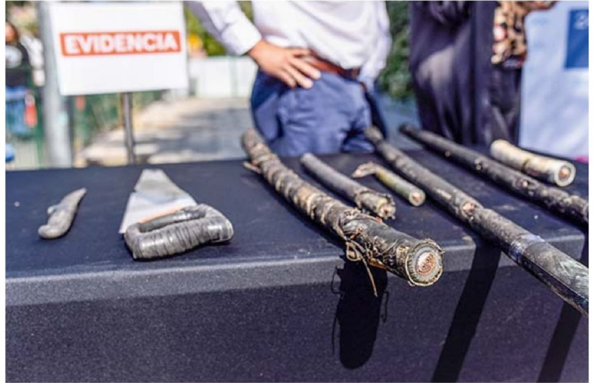
EL ROBO DE CABLES de cobre ocasiona interrupciones en el suministro eléctrico y también afecta las telecomunicaciones y representa un riesgo para la seguridad pública.
