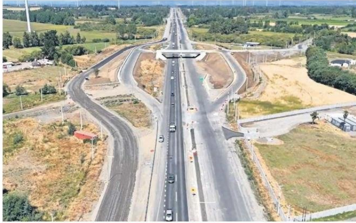
El proyecto contempla catorce estructuras a desnivel y 23 pasarelas peatonales.
