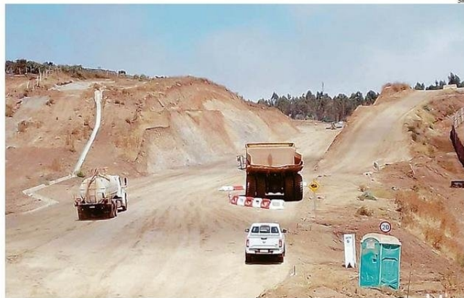
LAS OBRAS CONTEMPLAN LA AMPLIACIÓN DEL TRAZADO EN UNA RUTA CLAVE PARA EL COMERCIO EXTERIOR.
