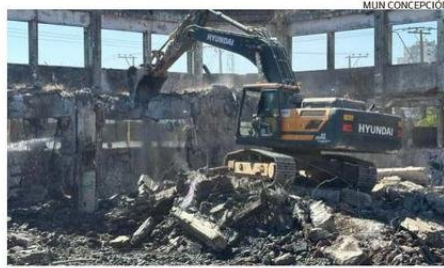
Desde el municipio informaron que las obras están paralizadas.
