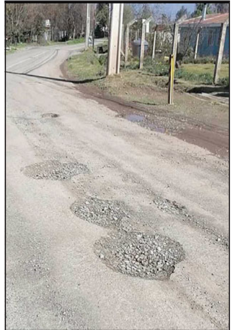
Acá se pueden apreciar hoyos en la calle, un problema sin resolver en San Rafael.
