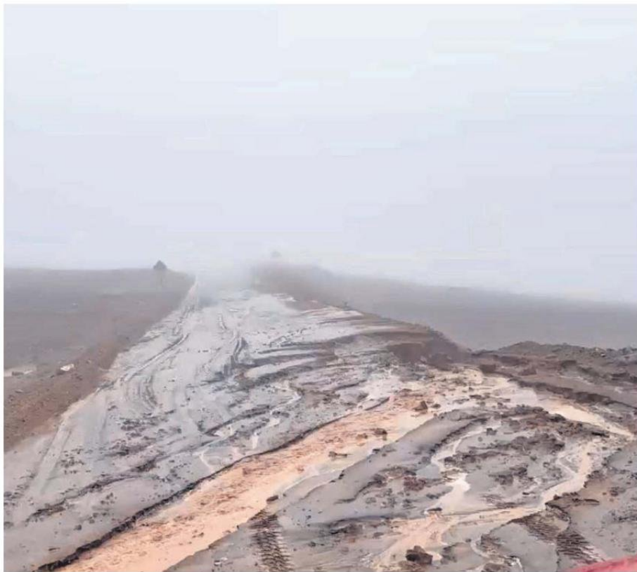
LA MAYOR AFECTACIÓN SE HA GENERADO EN ALGUNOS CAMINOS DEL TAMARUGAL
