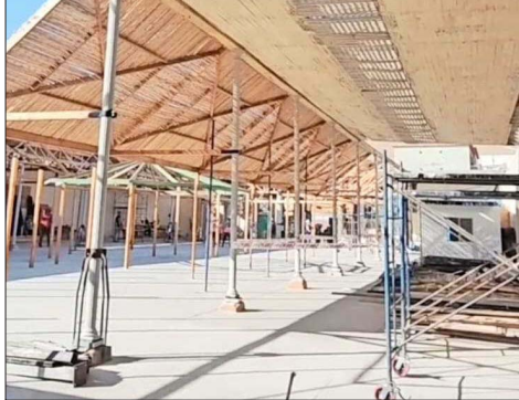
ARICA. — En este recinto patrimonial hoy se interviene mediante un proceso de reposición de sus instalaciones.
