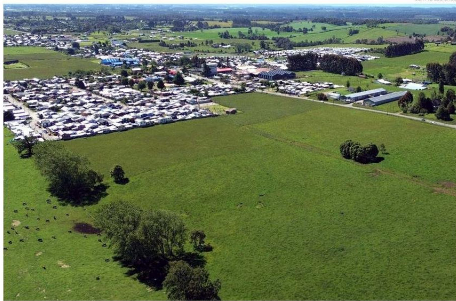
EN UN TERRENO DE NUEVA BRAUNAU, CEDIDO POR EL SERVIU AL MUNICIPIO DE PUERTO VARAS, SE CONSTRUIRÁN VIVIENDAS SOCIALES.
