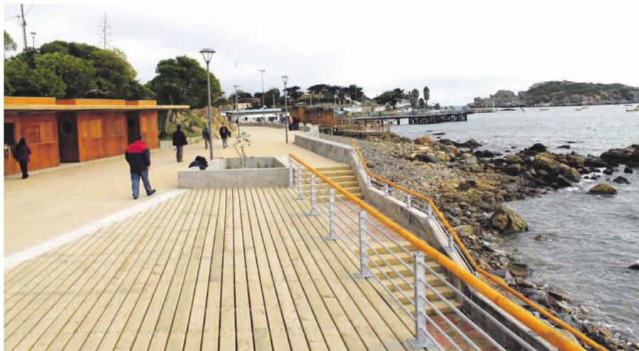
La planta desaladora ubicada en Pichidangui ha sido blanco de críticas desde que comenzó a operar en el año 2023.
