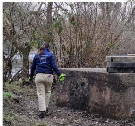
LOS FISCALIZADORES INSPECCIONARON LAS FALLAS EN LA CÁMARA.
