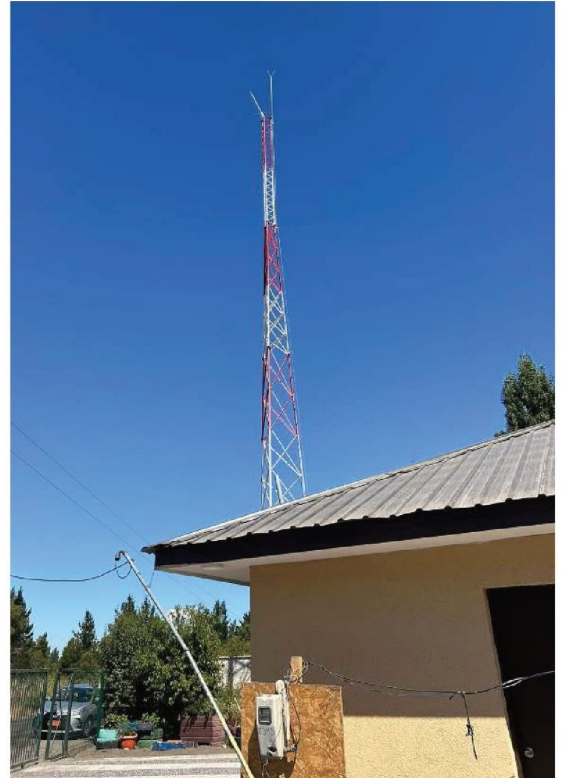
LA FALTA DE SEÑAL DE TELÉFONO y de internet se ha convertido en un problema para los vecinos de varios sectores rurales de la zona, como los de El Aromo en Los Ángeles.
