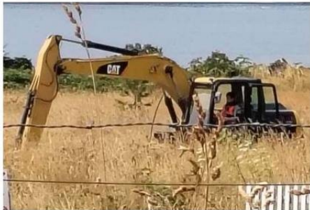
MAQUINARIA YA ESTÁ EN LA ZONA DE TRABAJO.
