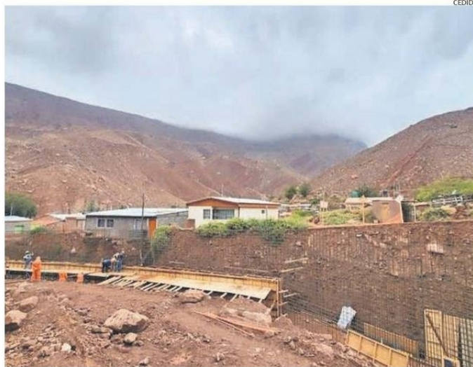
LOS TRABAJOS DE MITIGACIÓN QUE REALIZA EL MOP EN LA LOCALIDAD DE RÍO GRANDE.
