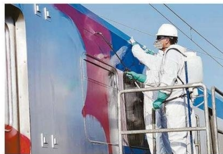
DESDE EFE VALPARAÍSO YA TRABAJAN EN REPARAR LOS DAÑOS.
