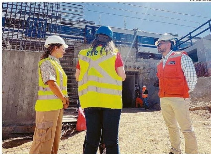
HACE ALGUNAS SEMANAS, AUTORIDADES VISITARON LAS OBRAS EN TERRENO.
