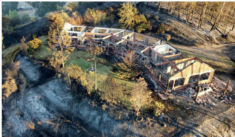
El incendio de la casa ocurrió en el sector de Docamávida, comuna de Curepto, El Maule.
