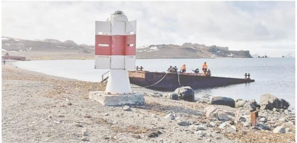
Ayuda a la navegación en bahía Fildes, fundamental para guiar a los navegantes en las aguas del océano austral.
