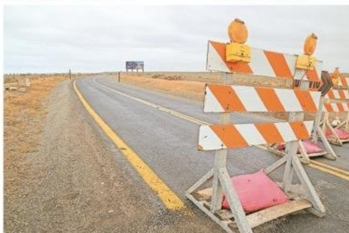
En ejecución se encuentran la pavimentación de 86 kilómetros de rutas.
