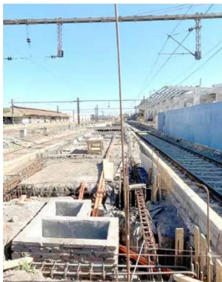
Desde EFE indicaron que en el más breve plazo, se "procederá a llamar a una nueva licitación para la continuación de las obras" (imagen: Carlos Ruz F.).
