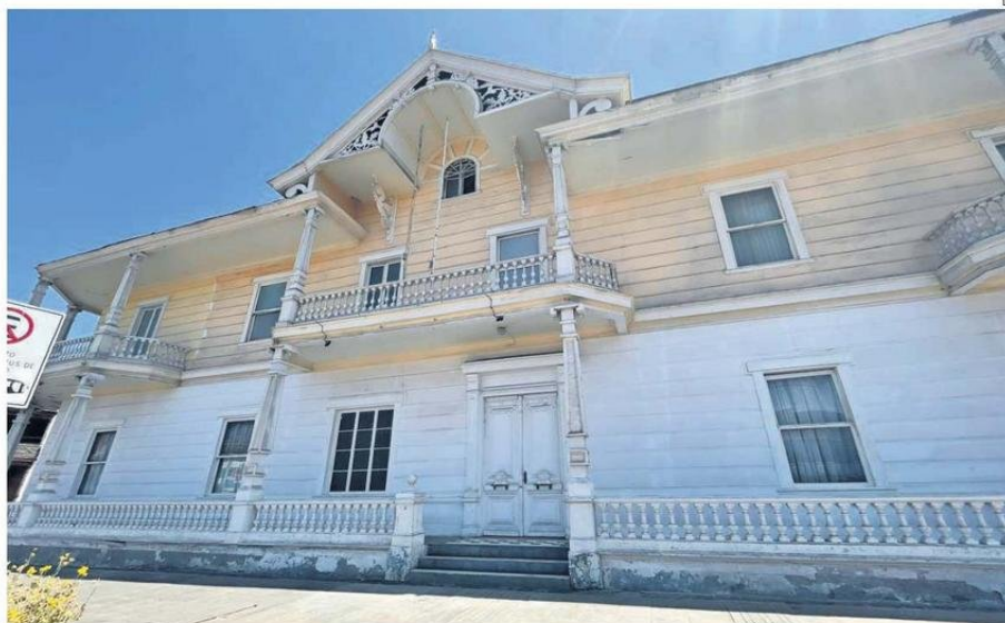
UNO DE LOS PROYECTOS A RETOMAR ES LA RESTAURACIÓN DE LOS VITRALES DEL PALACIO, LOS CUALES PERMANECEN SIN CRISTALES.
