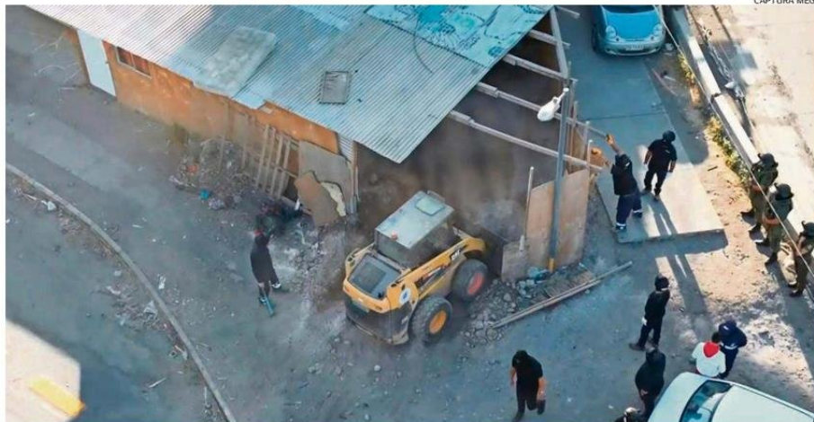
LAS 18 VIVIENDAS DEMOLIDAS SE ENCONTRABAN SIN HABITANTES.
