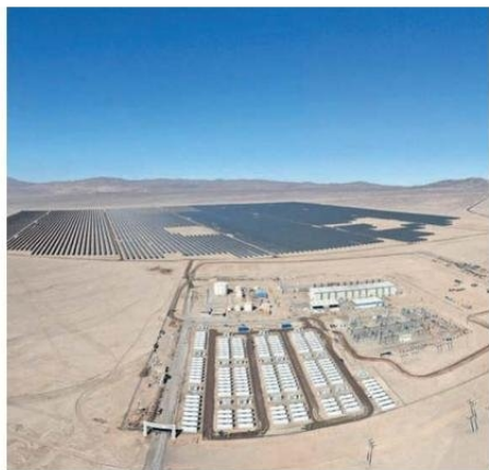
BESS TAMAYA COMENZÓ SU CONSTRUCCIÓN EN AGOSTO DE 2023.
