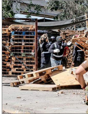
DEMOLICIÓN.— Operativo en Maipú que terminó con la demolición de 18 viviendas.
