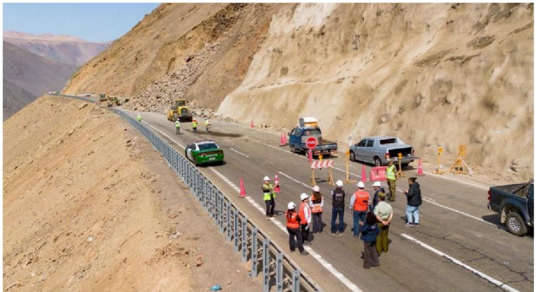
▶ A inicios de octubre de 2024, desprendimientos de rocas en la cuesta Chinchorro obligaron al cierre de la Ruta 5 Norte.
