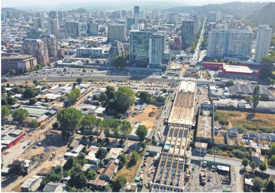
El mayor avance de los trabajos se observa en la franja correspondiente a Aurora de Chile y hoy comienza fase decisiva del proyecto.
