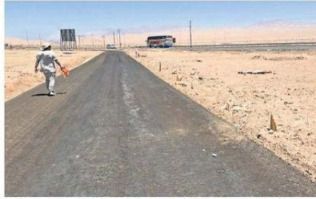
HAY DAÑOS EN EL CERCO PERIMETRAL, POSTES Y ALUMBRADO.
