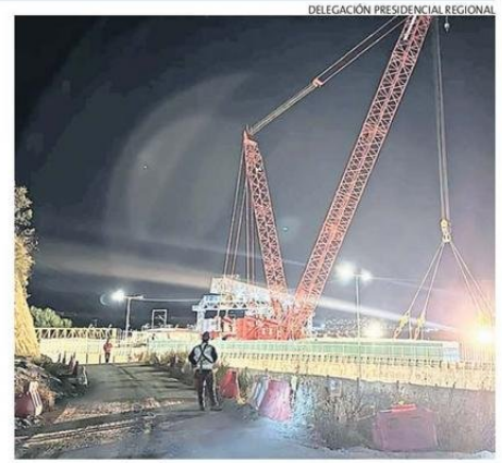
AYER SE INSTALÓ LA ÚLTIMA VIGA DEL NUEVO PUENTE FERROVIARIO.
