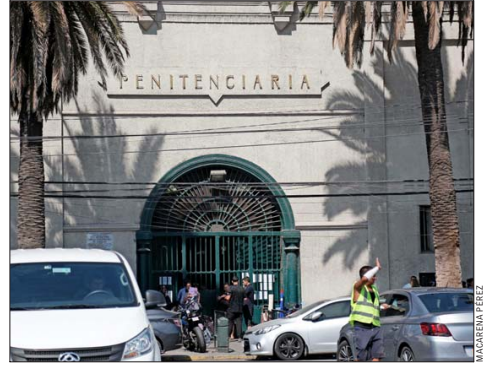
Se detectó que cuatro equipos de inspección por rayos X y dos de ondas milimétricas —recibidos entre noviembre de 2023 y febrero de 2024— no se estaban utilizando.
